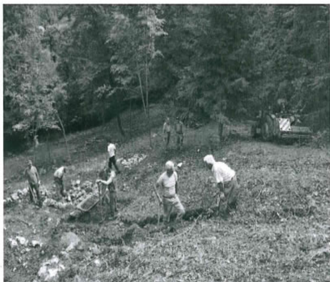
Lavori sul Monte Nagià-Grom
