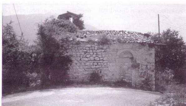
La chiesa di S. Tommaso prima dei lavori di restauro
