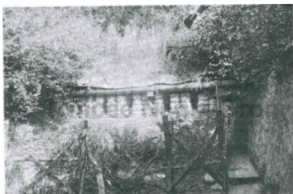
Sbaramento stradale a Tierno
